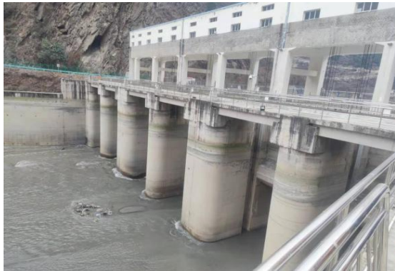
图11 大坝闸门全开
